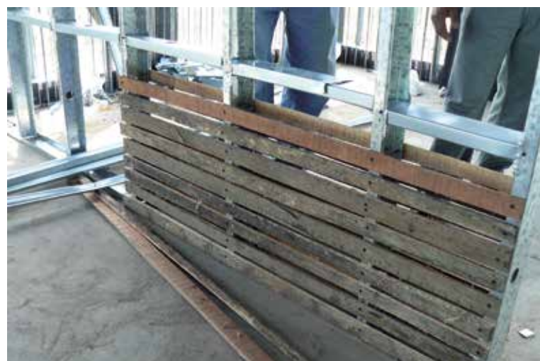
Las casas de tierra y las modulares en marcos de concreto, dos soluciones de vivienda con sello UPB.
