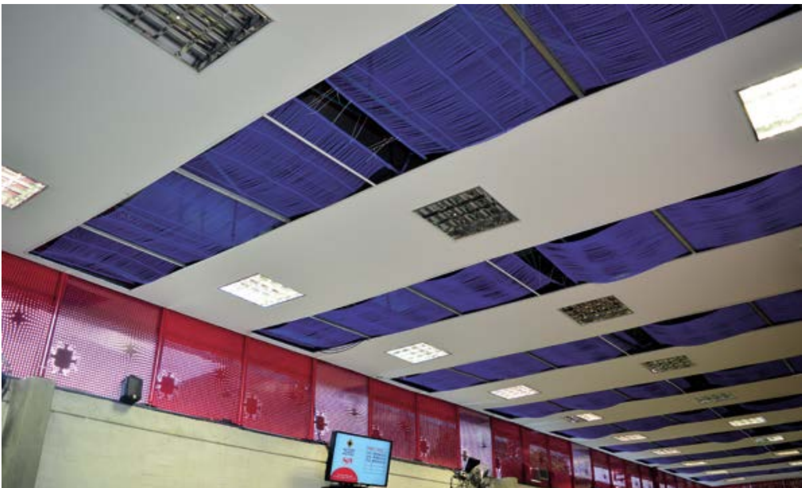
Montaje del techo radiante al interior del bloque 24.
