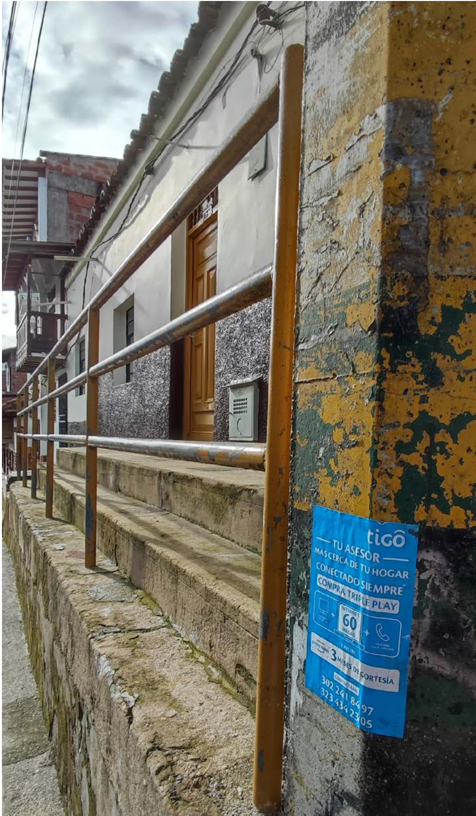
Foto 6. Estructura metálica sobre la que se pueden trazar las líneas de fuga de la imagen (El Retiro, Antioquia).
